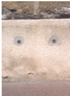
Photo 8 Tubes aérateurs en soubassement de mur
