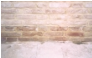
Photo 7 Barrière anticapillaire (plaques de plastique insérées à l'emplacement des joints de maçonnerie)
